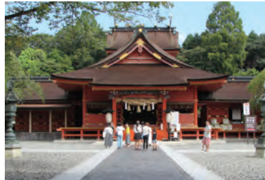
▲寄棟造の社殿屋根の奥に「浅間造」と呼ぶ社殿の屋根が。
