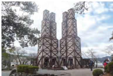
▲韮山反射炉。外壁を補強する鉄フレームは、1957年の保存工事で追加されたもの。
