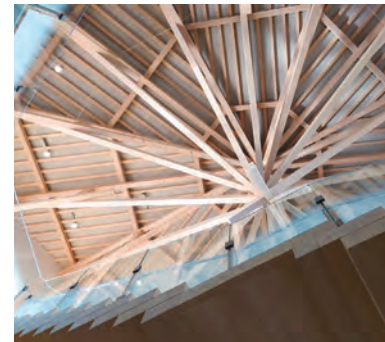
▲内部階段越しに仰ぎ見る天井部架構。
